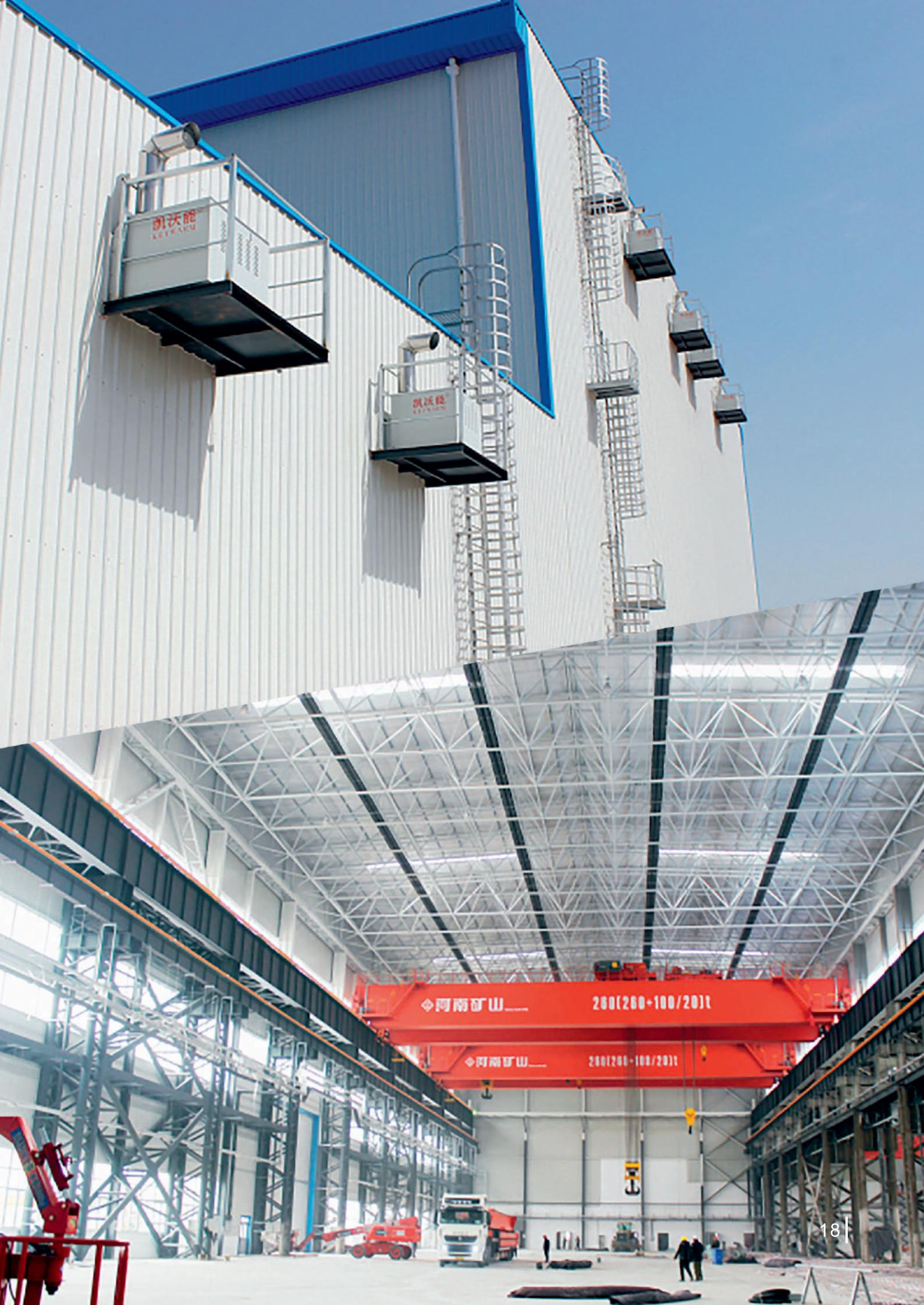
**BP-LTVU** Ленточные излучатели с 2-ступенчатой горелкой
